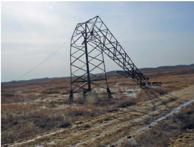
Рис. 7. Разрушение опор в районе стыка нижнего и среднего пояса
