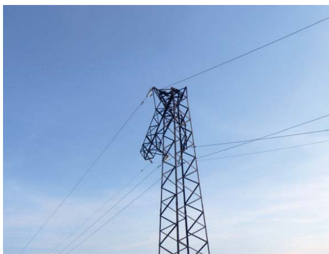
Рис. 12. Разрушение опор в районе траверсы
